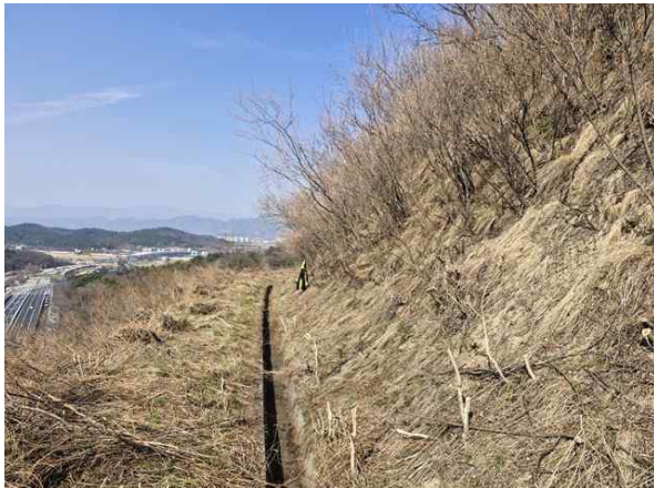
3소단 배수로 전경
