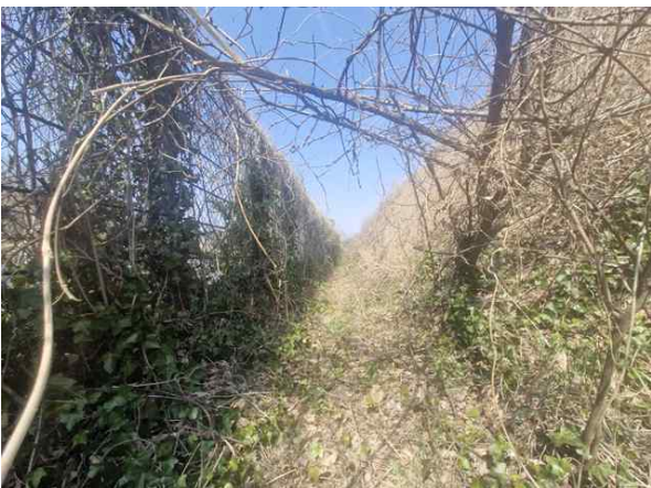
낙석방지울타리 및 하부 전경
