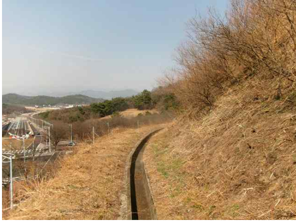
1소단 배수로 전경
