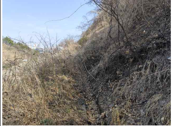
2소단 배수로 전경
